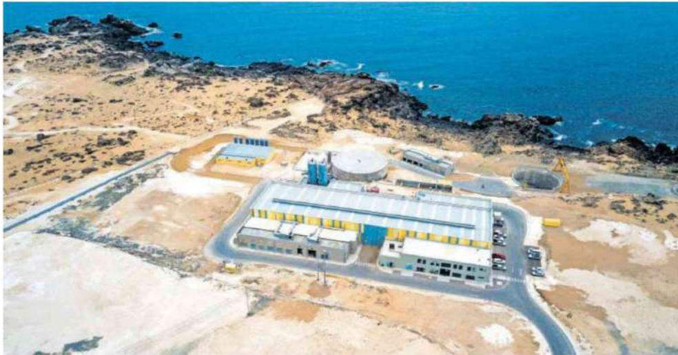
Planta desaladora en la región de Atacama (Chile) de GS Inima. Fotografía cedida por la empresa.
