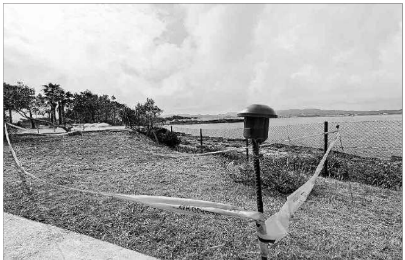
Imagen de archivo de los trabajos para poner a punto la desaladora modular. Foto: CAIB
