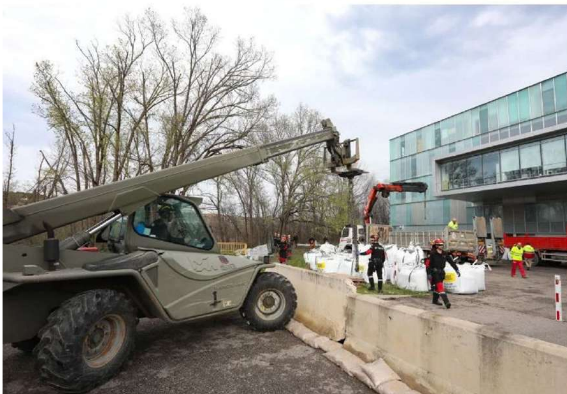
La crecida del Tajo de marzo obligó a intervenir de la UME para proteger el Hospital de Paraplégicos H. FRAILE
