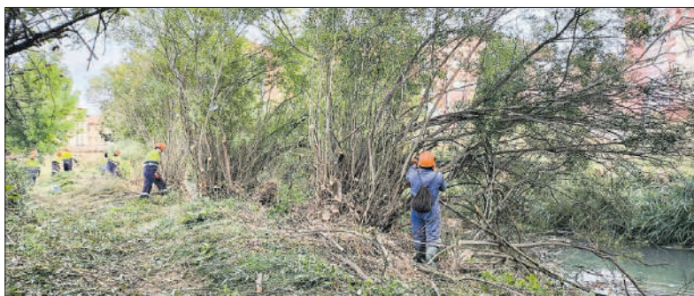
Dos de los puntos en los que se está trabajando desde el pasado 8 de septiembre.
